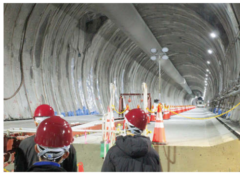
4 札幌トンネル内の様子
