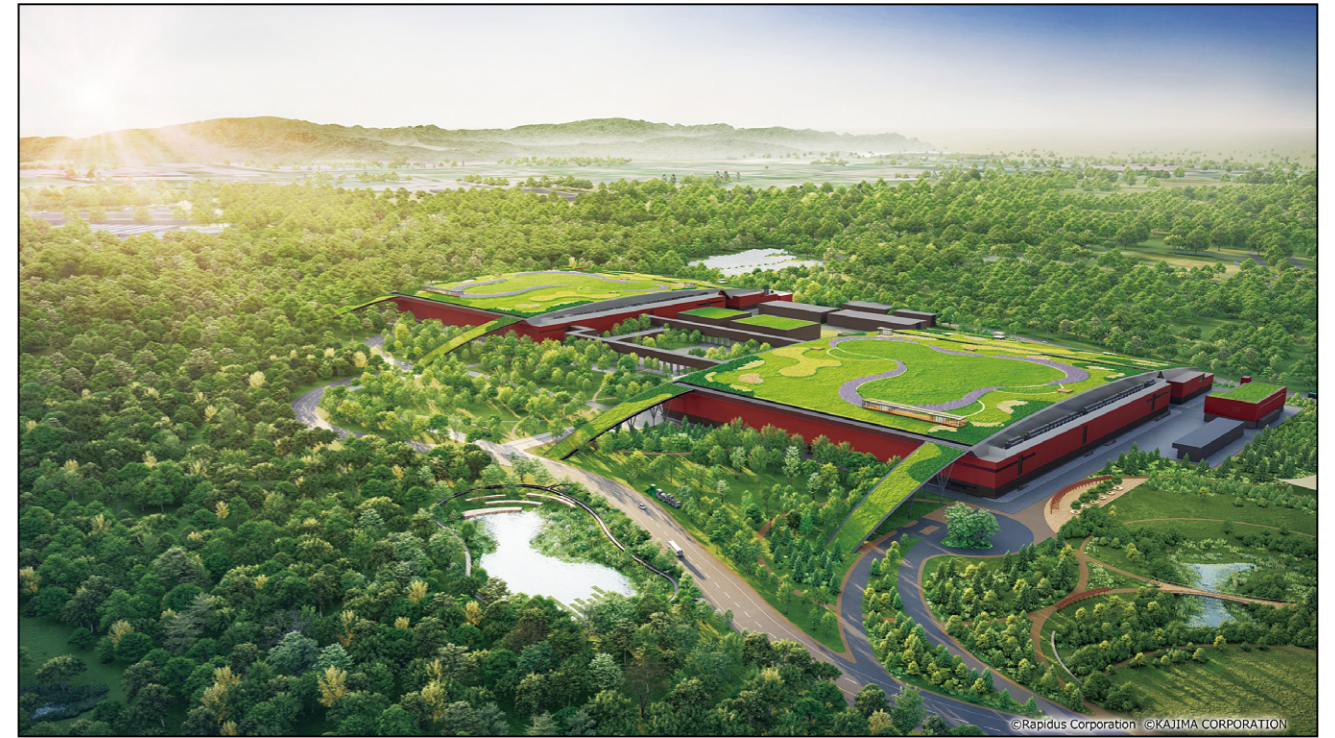
北海道千歳市に建設中の IIM は、自然との調和と徹底的な環境負荷低減を目指しています。
